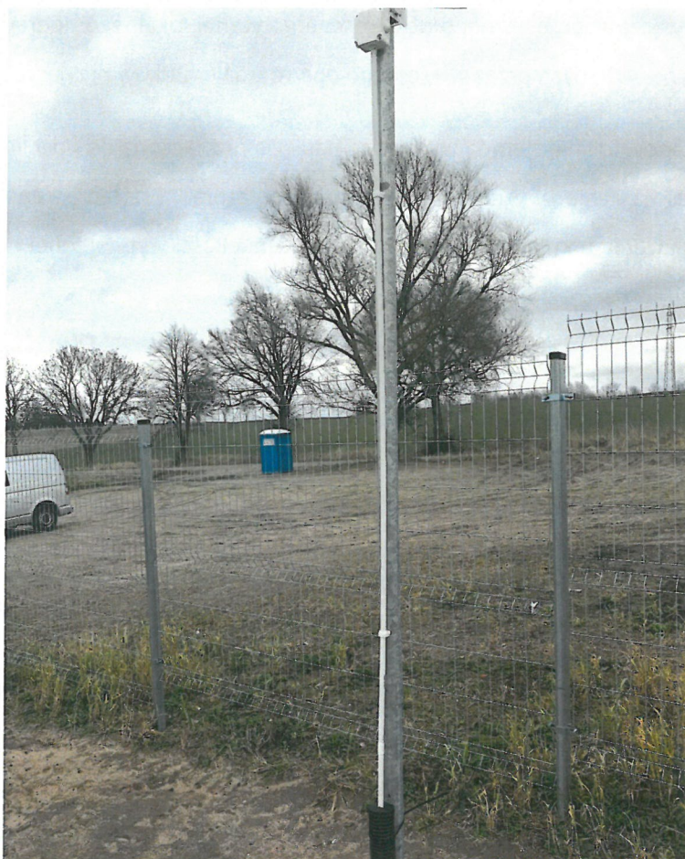
Ryc. nr 12 Ogrodzenie farmy fotowoltaicznej uniesione nad gruntem i przykładowy maszt do oświetlenia
