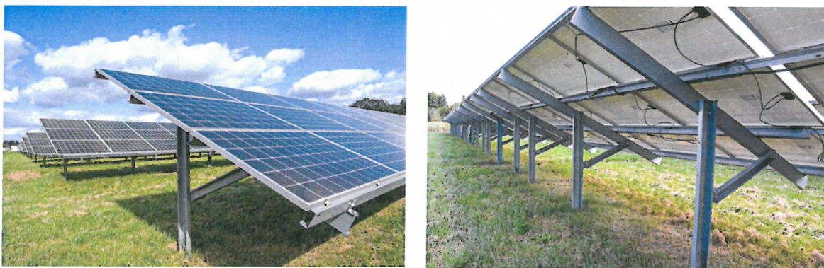
Rys. 3.5. Przedstawienie przykładowych konstrukcji pod panele fotowoltaiczne
