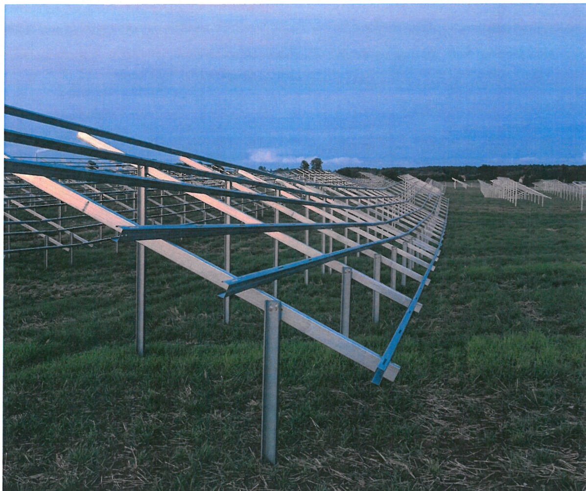
Ryc. nr 8 Konstrukcje wsporcze posadowione w gruncie bez fundamentowania cechują się małym oddziaływaniem na glebę.
