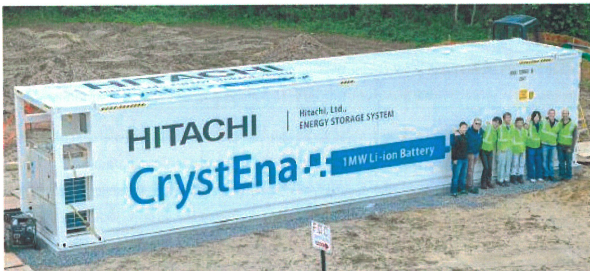
Ryc. nr 12 Przykładowy kontenerowy magazyn energii o pojemności 1 MW, Hitachi „CrystEna”. Inwestor planuje zastosowanie wtapiających się kolorów kontenera.
