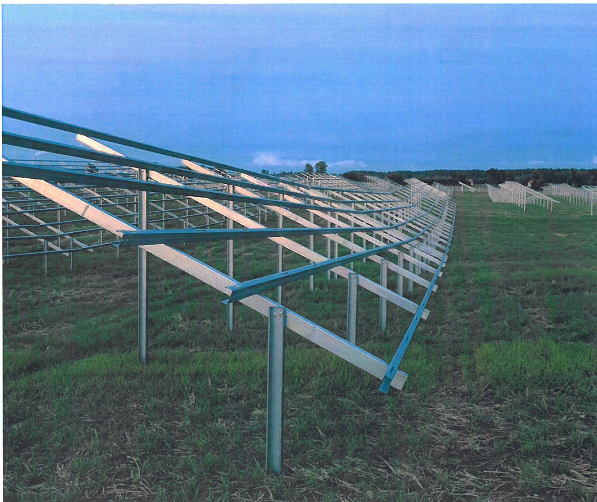
Ryc. nr 9 Konstrukcje wsporcze posadowione w gruncie bez fundamentowania cechują się małym oddziaływaniem na glebę.
