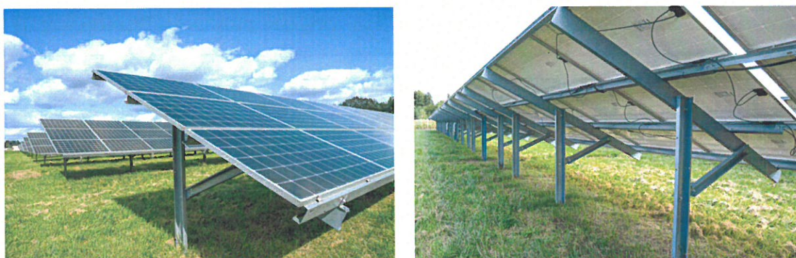
Rys. 3.5. Przedstawienie przykładowych konstrukcji pod panele fotowoltaiczne
