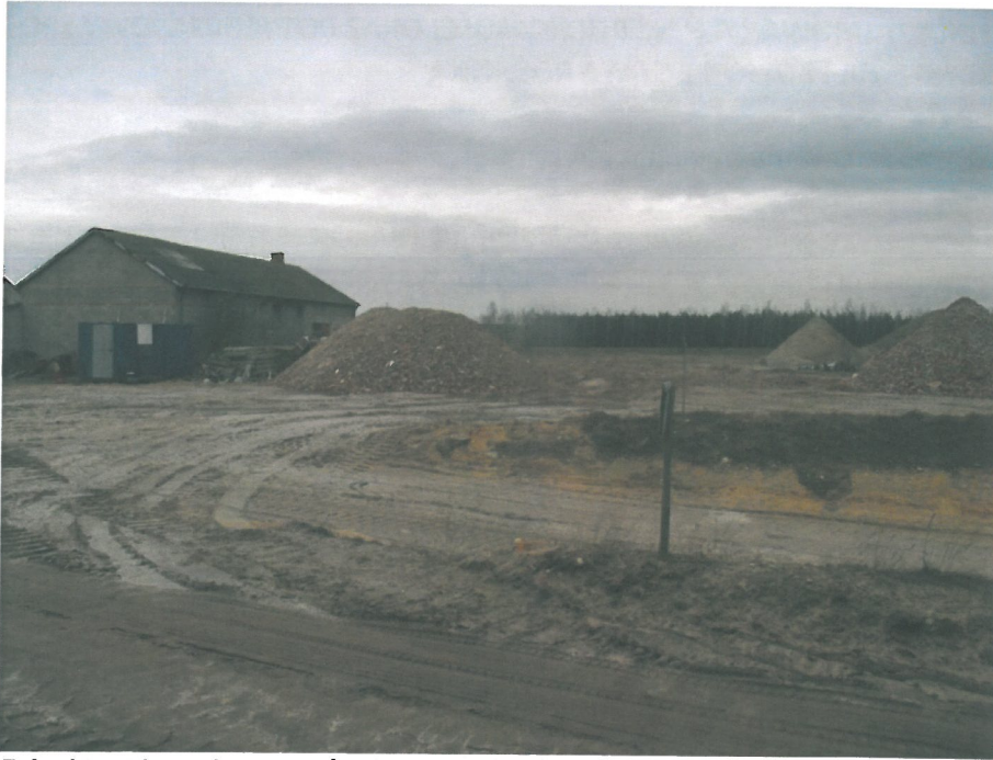
Fig. 3 Zabudowania na dz. nr 395/2. Na pierwszym planie droga wyjazdowa z wyrobiska
