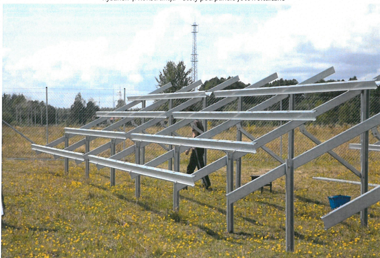
Rysunek 4. Konstrukcja – stoły pod panele fotowoltaiczne
