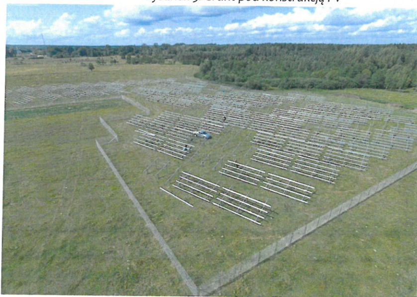
Rysunek 5. Grunt pod konstrukcją PV
