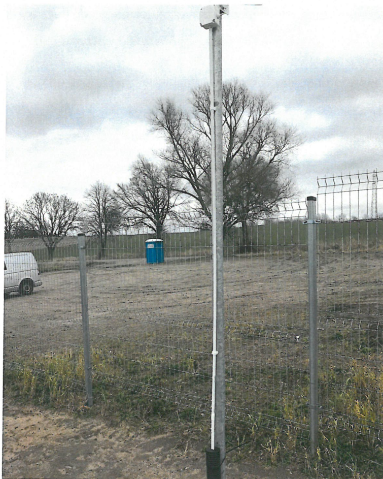
Ryc. nr 12 Ogrózenie farmy fotowoltaicznej uniesione nad gruntem i przykładowy maszt do oświetlenia
