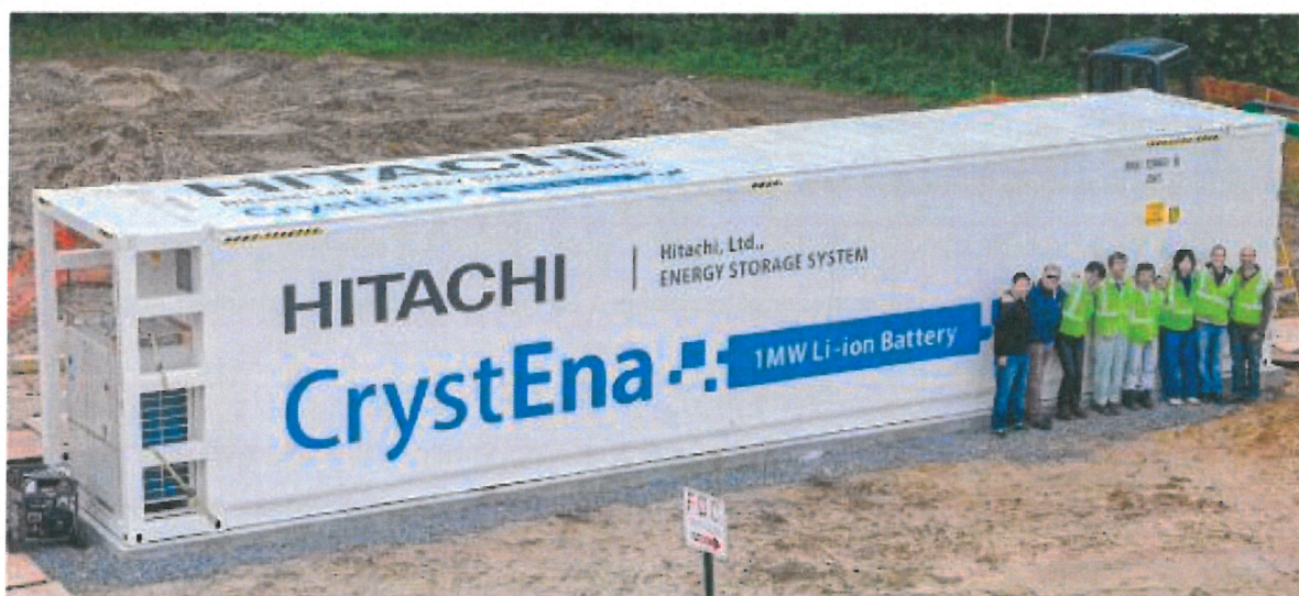
Ryc. nr 11 Przykładowy kontenerowy magazyn energii o pojemności 1 MW, Hitachi „CrystEna”. Inwestor planuje zastosowanie wtapiających się kolorów kontenera.
