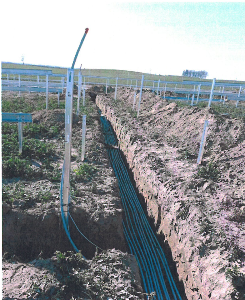
Rysunek 25 Przewody ułożone w wykopie
