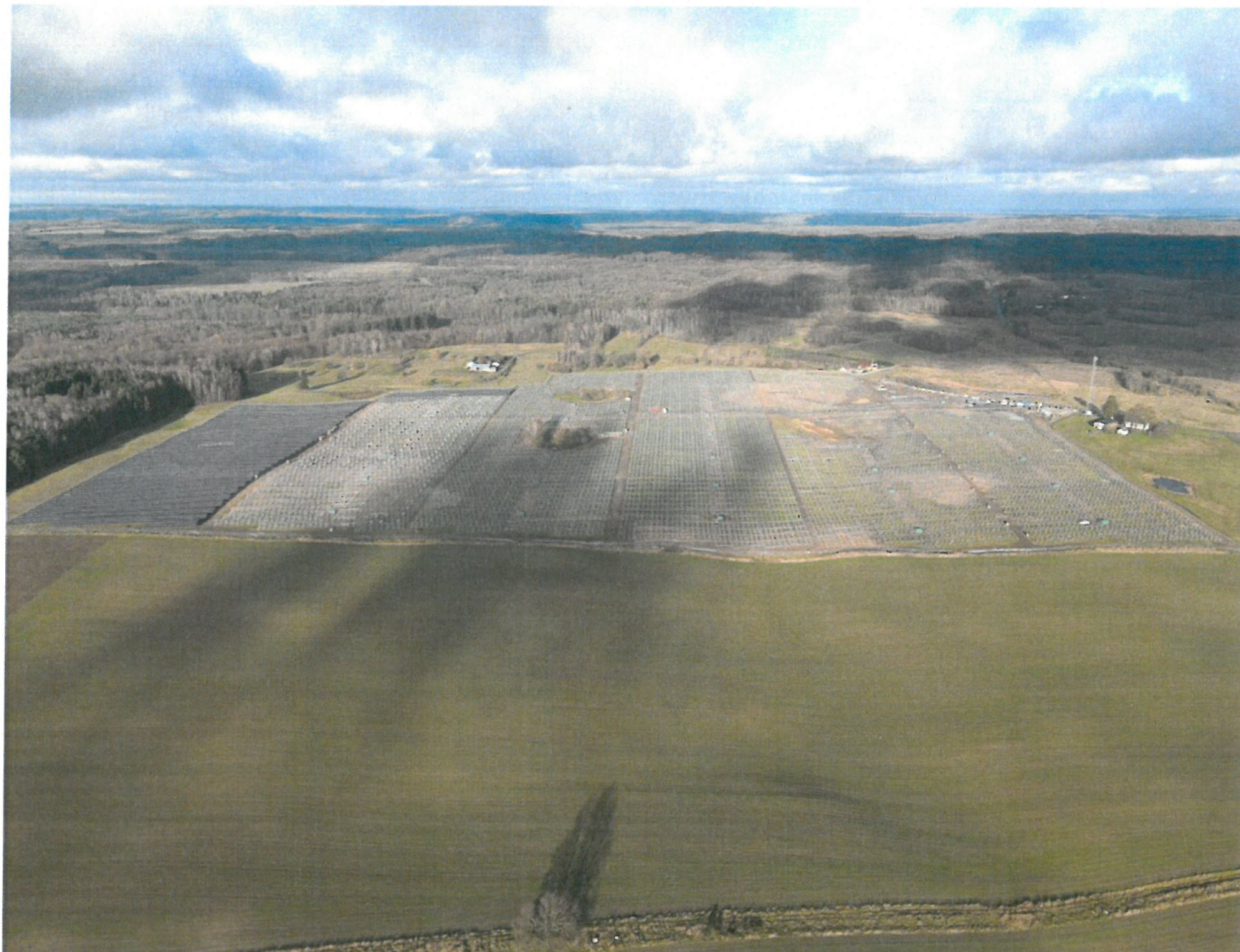
Rysunek 26 Proces montażu modułów fotowoltaicznych na konstrukcji szkieletowej
