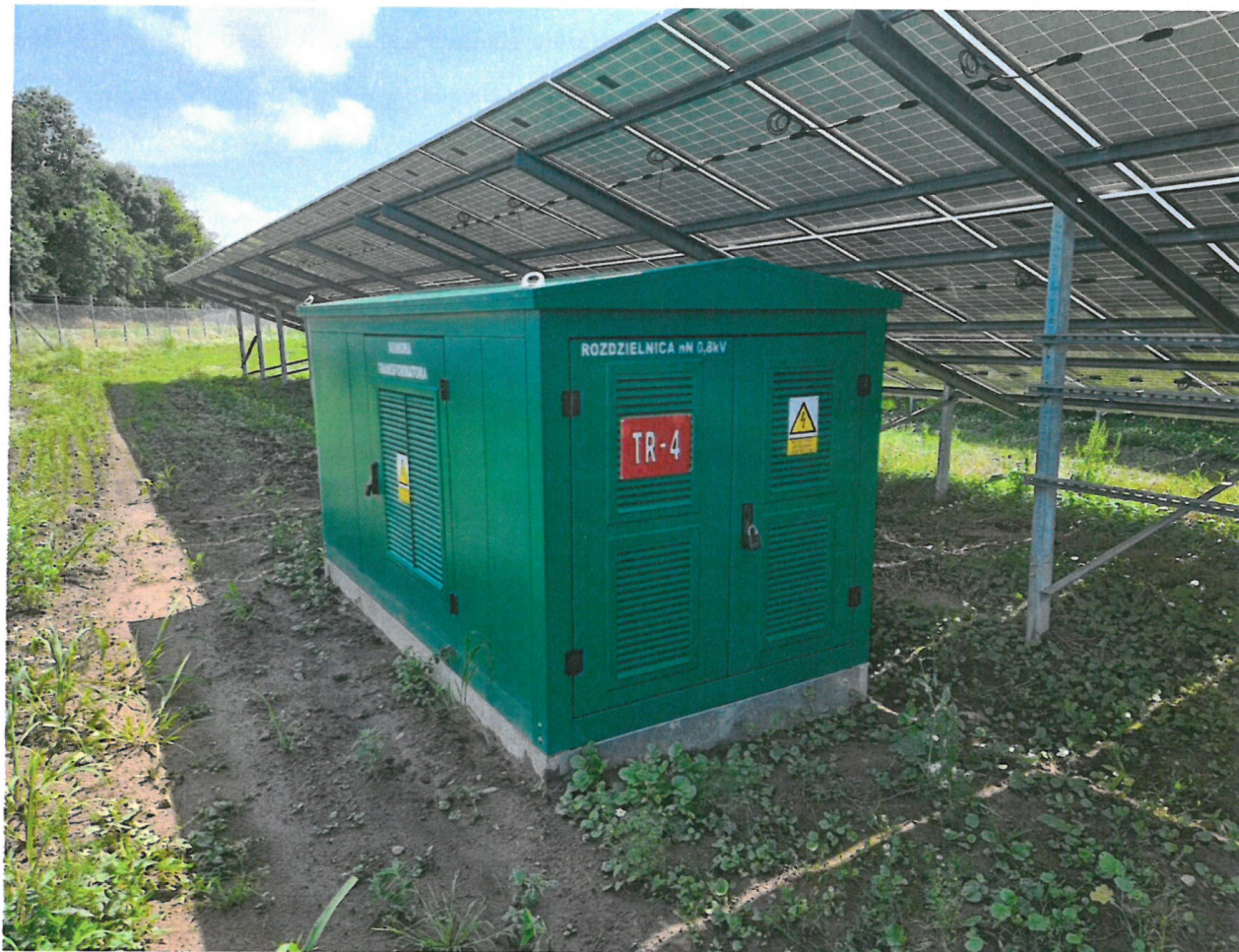
Rysunek 21 Wnętrze stacji transformatorowej o mocy 0,8 MVA
